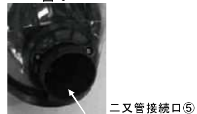
図-7 二又管接続口⑤の内面部
