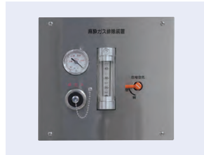
[ 麻酔ガス排除装置 ]
