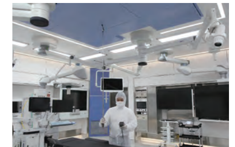
室内循環風速・風量測定
